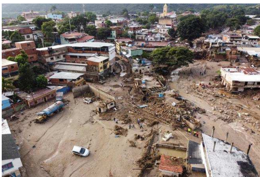
La zone touchée par un glissement de terrain lors de fortes pluies à Las Tejerias, au Venezuela, le 10 octobre 2022. YURI CORTEZ / AFP
